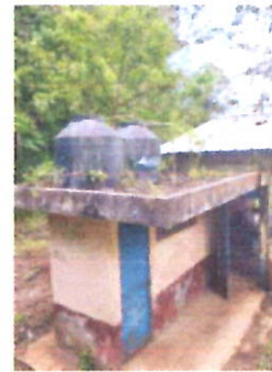
IMPERMIABILIZACION DE LOSA, NIVELACION E IMPERMIABILIZACION DE LOSA EN MAL ESTADO
